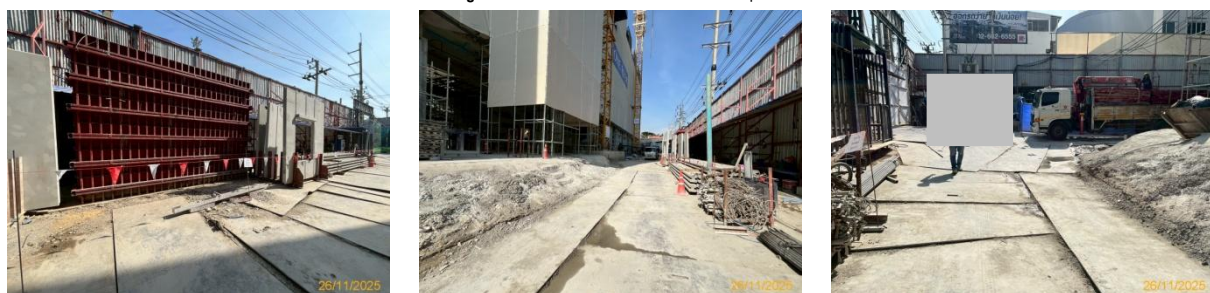
รูปที่ 2.2-13 สภาพถนนภายในพื้นที่ก่อสร้าง และการปูแผ่นเหล็ก
