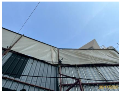
รูปที่ 2.2-25 ระบบสเปรย์น้ำ เพื่อลดฝุ่นละออง
